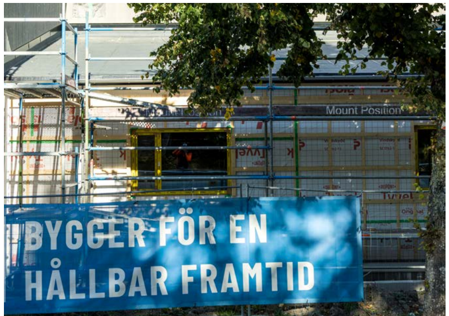
Pågående nybyggnation av Bojarskolan etapp 2
